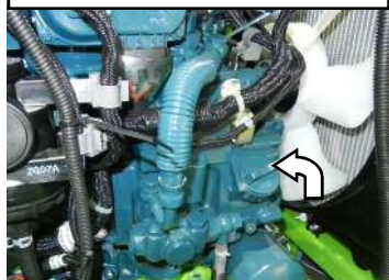
エンジンオイル (カバー内)
